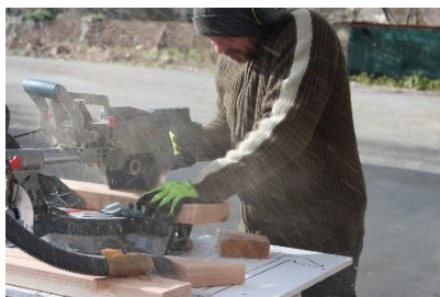
Découpe de bois Douglas (bois origine d'Amérique du Nord) en section 120mmx45mm pour réaliser les cloisons.
