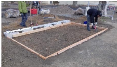
Installation du treillis soudé pour armer les fondations.
