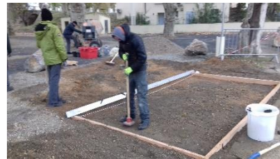
Compactage de la terre.
