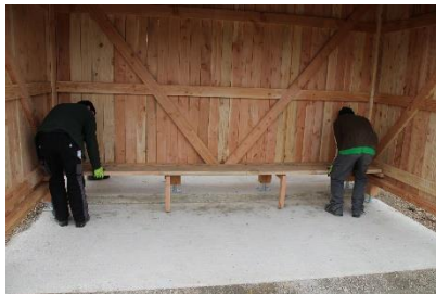
Pose et fixation des pièces de bois pour réaliser la banquette.
