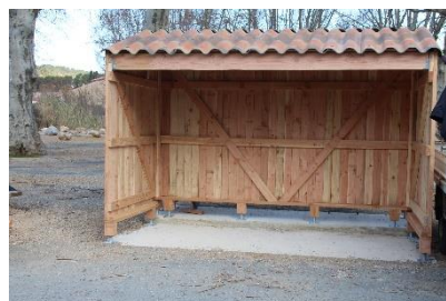
Mise en place des PST en fibro-ciment à l'aide de tirefonds de 130mm.
