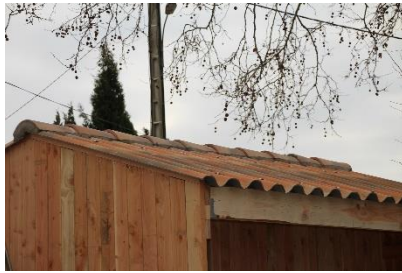
Maçonnage des tuiles-canal sur le faîtage à l'aide du mortier.
