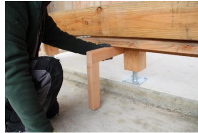
Fixation des pieds de la banquette à l'aide de scellement chimique.
