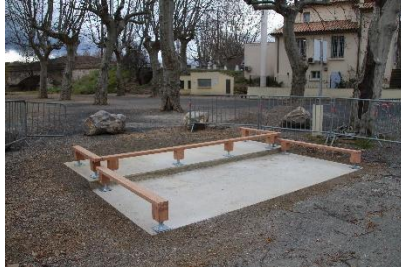
Pose de la base de l'abri.
