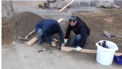
Mise à niveau et vissage du coffrage.
