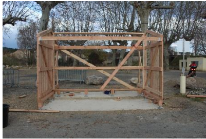
Vue d'ensemble : habillage des cloisons en cours.
