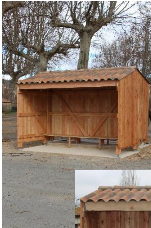
Abribus côté route
