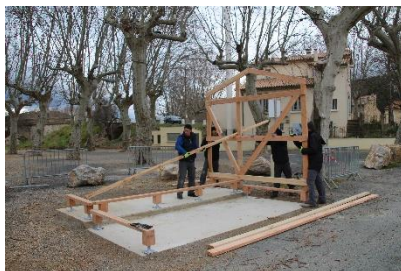
Fixation de la structure des cloisons à la base.
