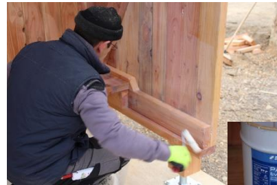
Application du vernis antigraffiti.
