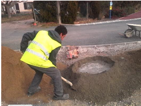
Préparation du béton* .
