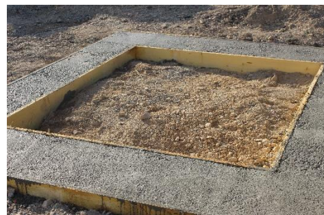
Dessus grossièrement lisser à l'aide d'une taloche* .
