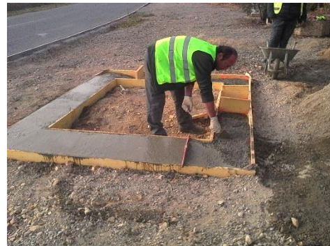
Remplissage du coffrage de béton.
