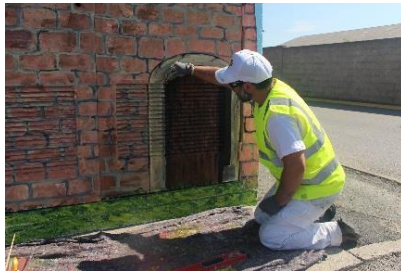
Réalisation de la porte d'entrée...
